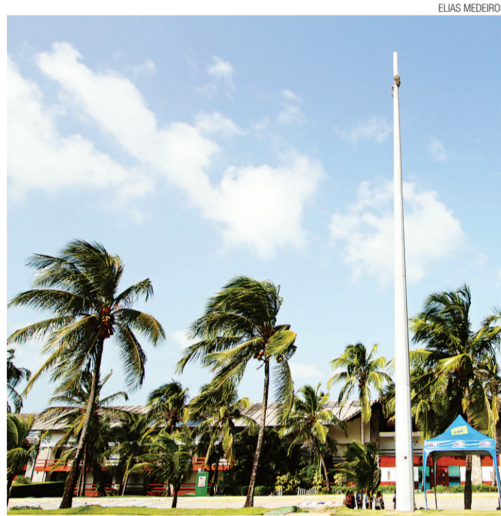
► Nova antena da TIM, instalada no Hotel Vila do Mar, Via Costeira
