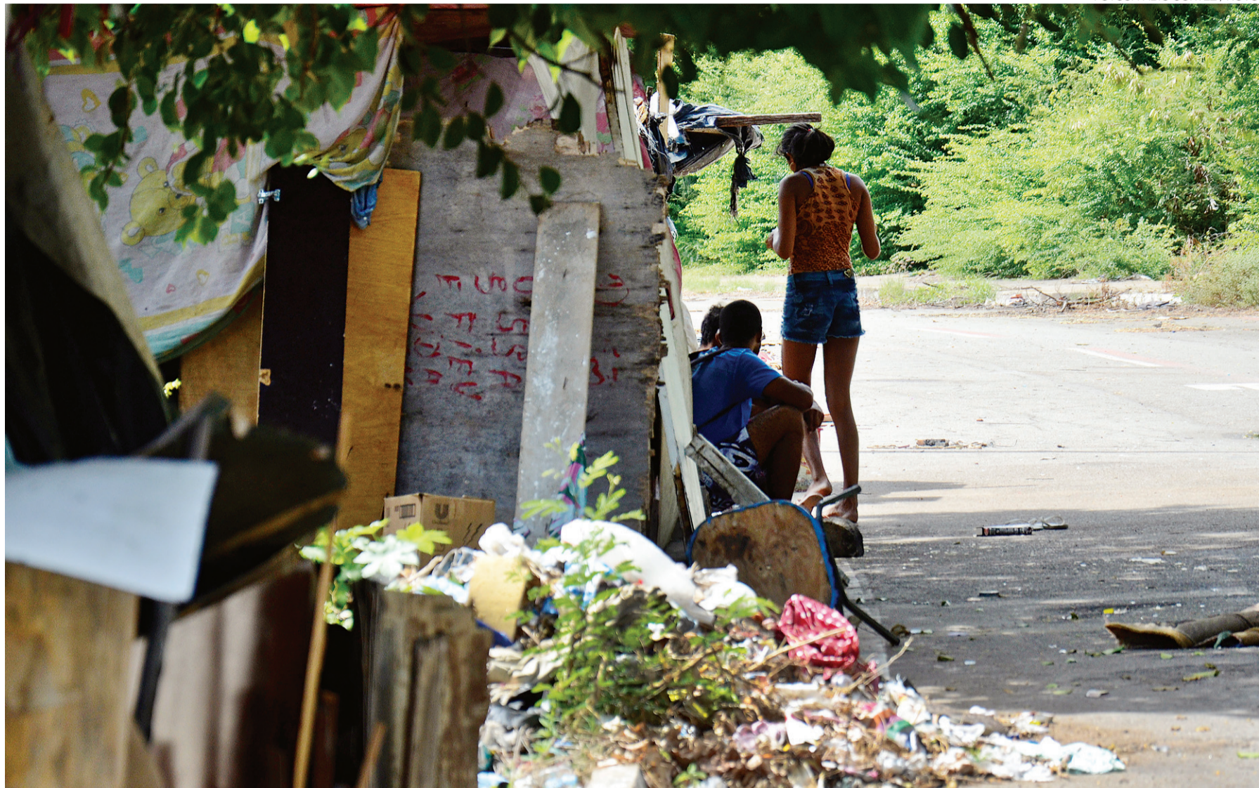
// Viaduto do Baldo foi ocupado por barracas, lixo e usuários de drogas; obras de reforma da estrutura têm previsão de entrega para dezembro deste ano
