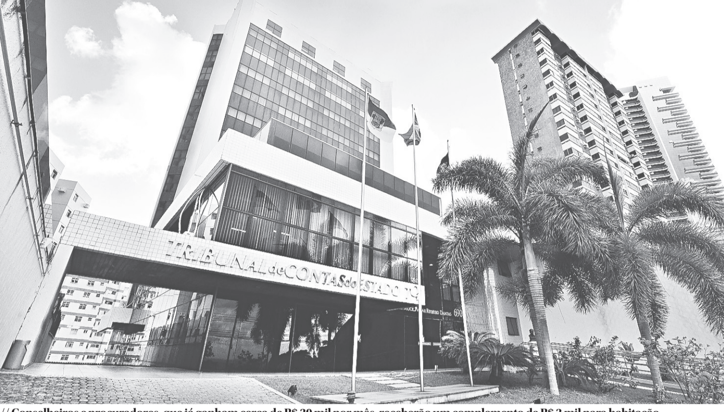
Conselheiros e procuradores, que já ganham cerca de R$ 30 mil por mês, receberão um complemento de R$ 3 mil para habitação
