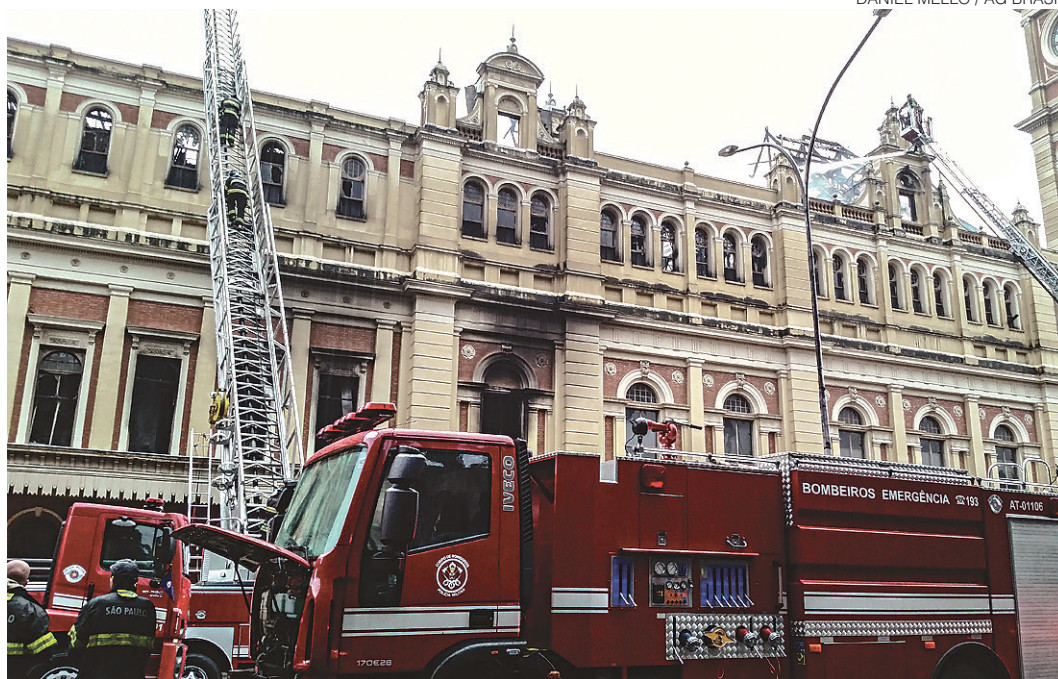
// Ocorrido em 21 de dezembro, o incêndio deixou um morto, o bombeiro civil Ronaldo Pereira da Cruz
