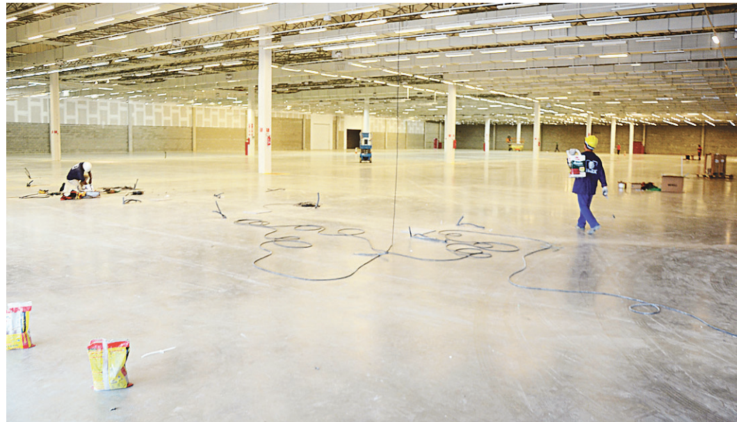
// Leroy Merlin em Natal está em fase final de acabamento e vai funcionar com 15 setores de vendas
