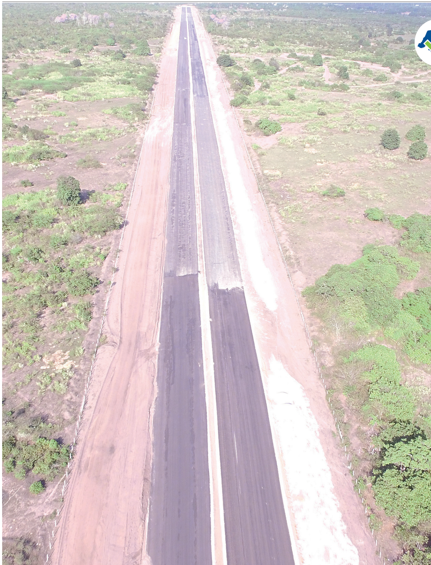
// A obra do acesso Sul do Aeroporto Internacional Aluizio Alves está estimada em R$ 90 milhões e possui 18 quilômetros de extensão
