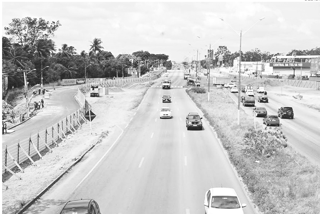
// Construção faz parte do conjunto de intervenções previstas para a BR-101, entre Natal e Parnamirim
