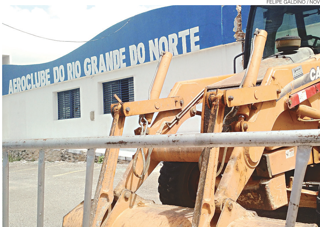
// As obras de restauração serão encerradas em dezembro e irão resgatar a aparência da década de 1950
