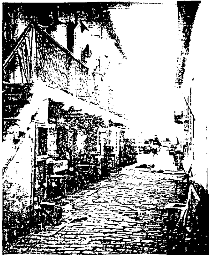
Cortiço na rua Carneiro Leão, bairro do Brás, São Paulo, 1942.
