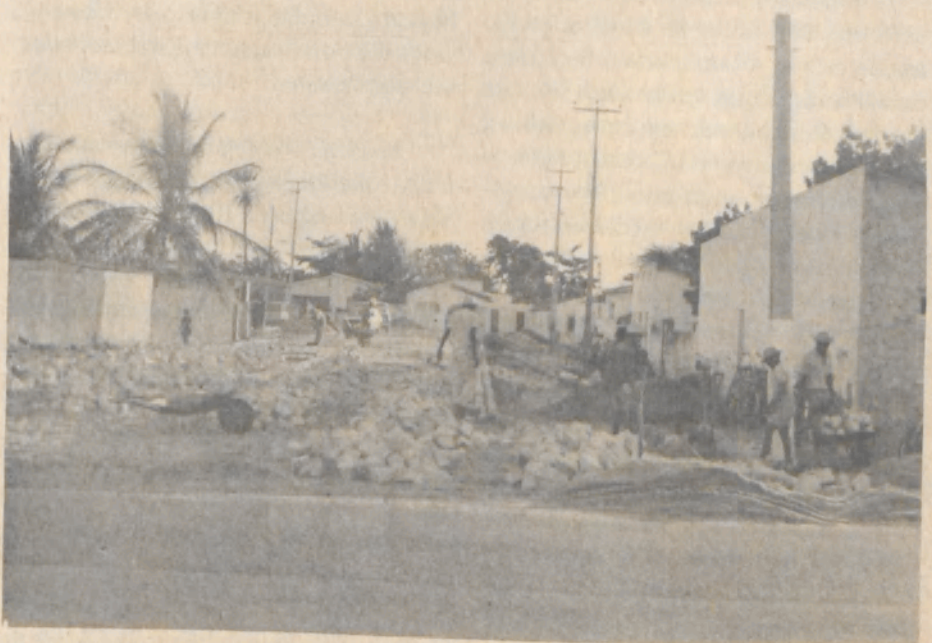
Nesses três últimos anos foram pavimentadas mais ruas do que em todas as administrações passadas.
