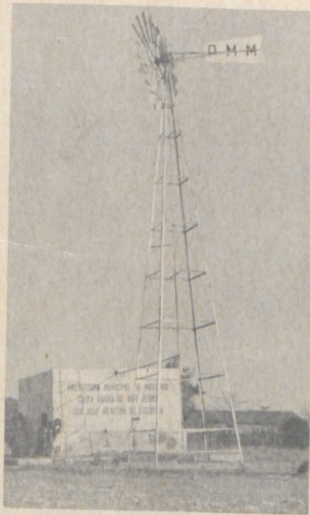
Com perfuratrizes da própria Prefeitura já foram perfurados 57 poços tubulares na zona rural, acoplados com caixas d'água e cataventos.
