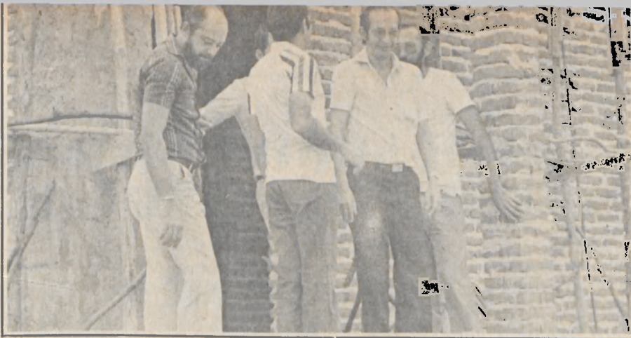
A presença da UFRN em obras constantes
