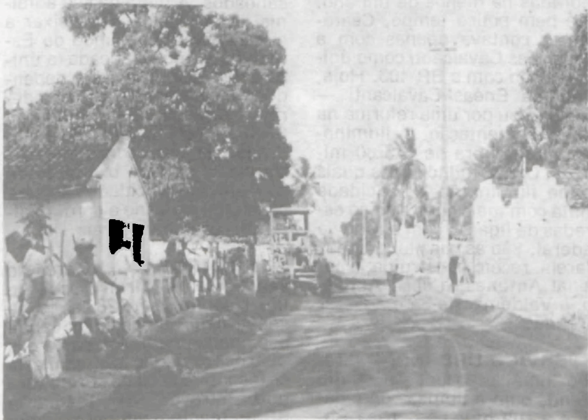
Ruas em obras: uma constante
