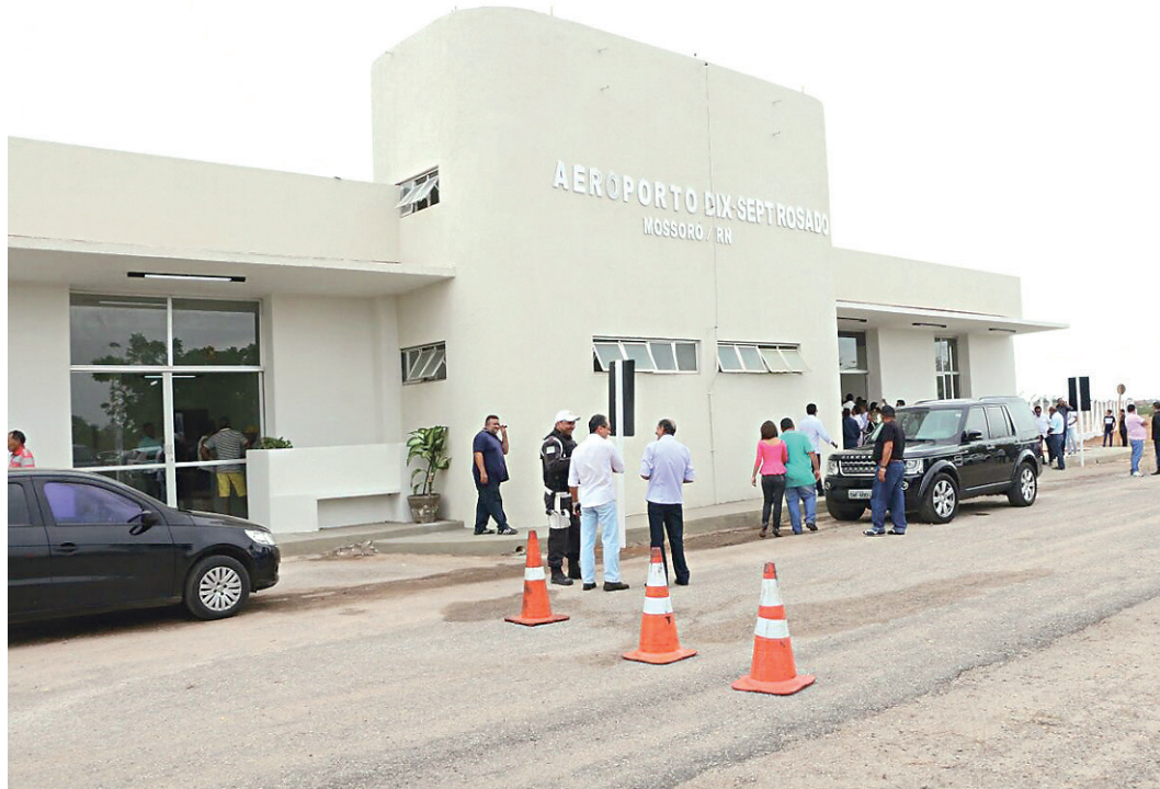
// Aeroporto Dix-sept Rosado, em Mossoró: reforma concluída
