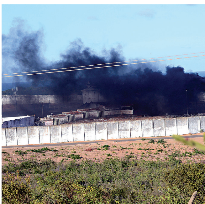
// Detentos do PCC tocam fogo no Pavilhão 3 do presídio
