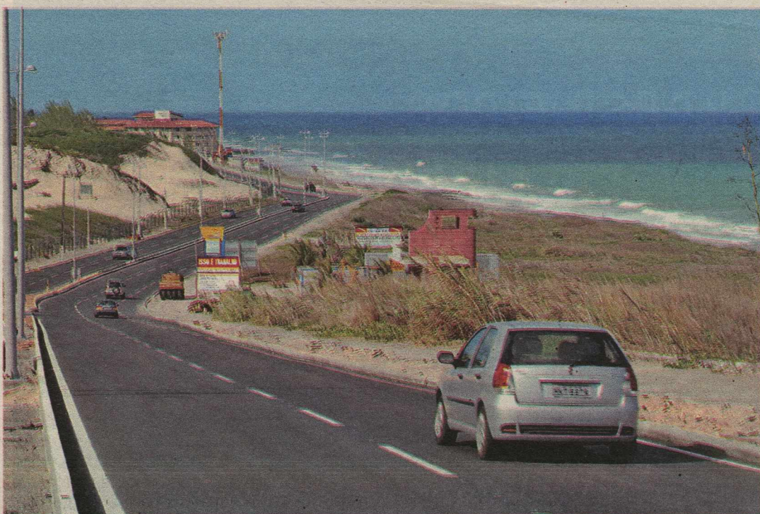
Na avenida, que recebe obras orçadas em R$ 13 milhões, ainda serão construídos calçadão, ciclovia e novos acessos
