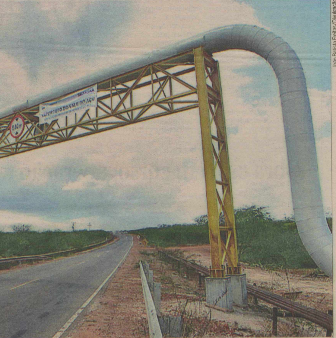
O Vaporduto, inaugurado em 20 de janeiro, tem 30km de extensão e vai garantir a injeção de 180t de vapor, por hora, nos campos de Estreito e Alto do Rodrigues
