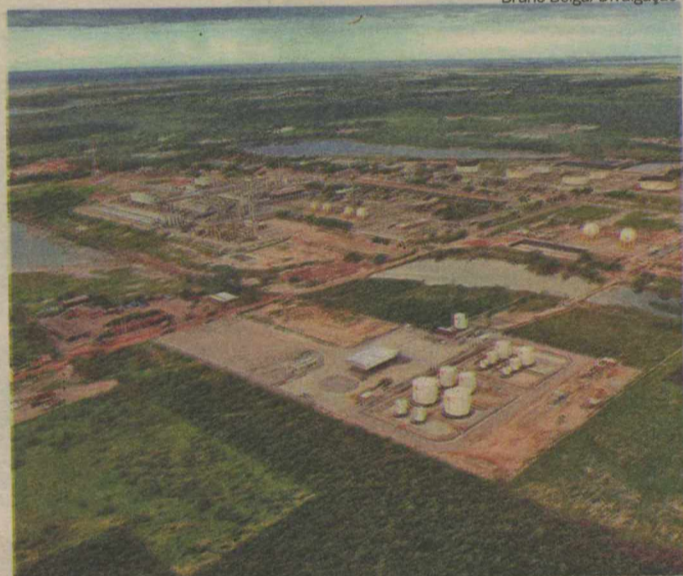
Vista aérea do Pólo Industrial onde está sendo construída a Clara Camarão
