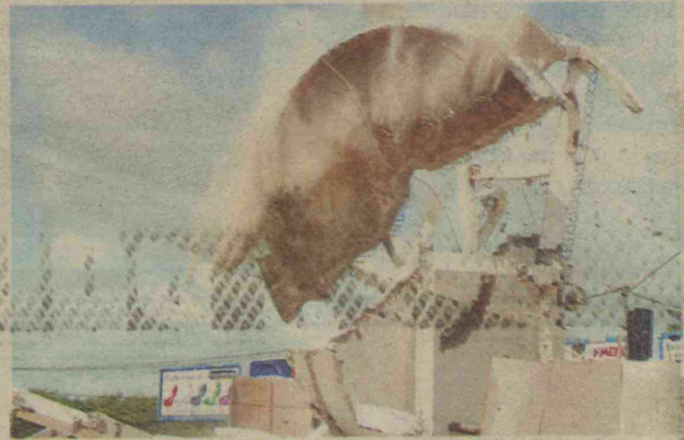
Estrutura, que estava sem uso, foi levada a baixo para realização de obras
