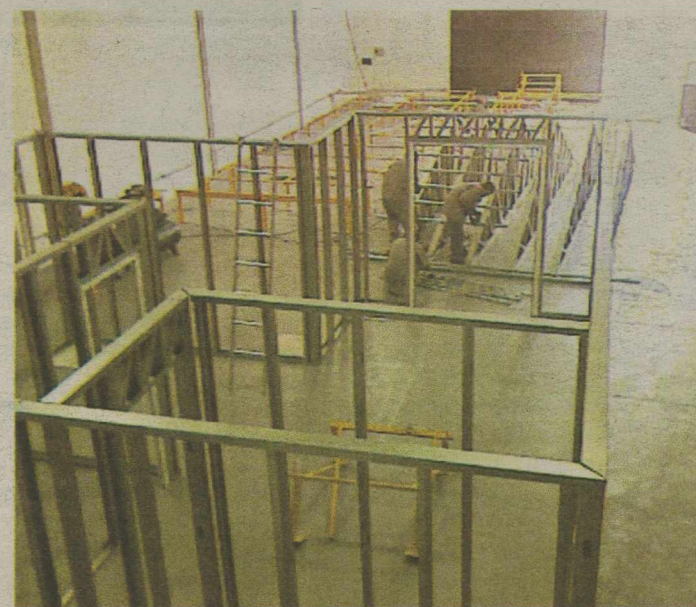
Casas são feitas com aço galvanizado, painéis estruturais e gesso acastonado
