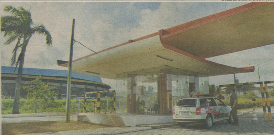
Entre os serviços previstos está a drenagem do Centro Administrativo, no bairro de Lagoa Nova
