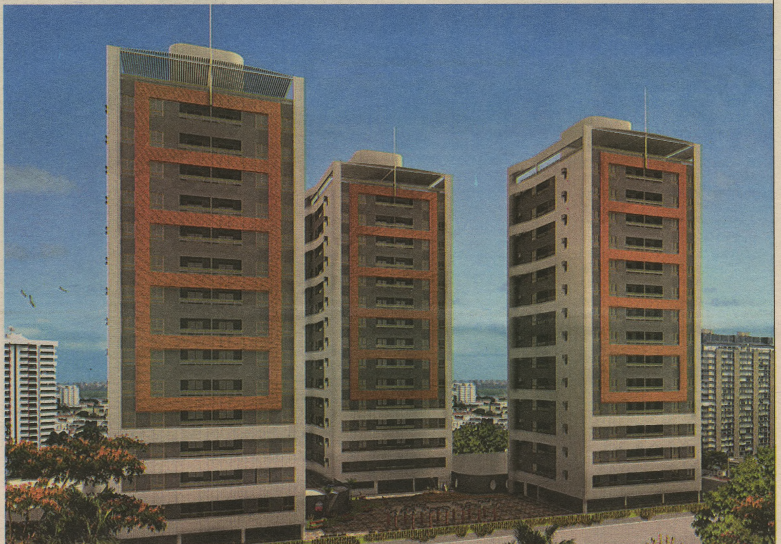
Maquete virtual do empreendimento, que tem vista para o mar e para o Rio Potengi: dos 167 apartamentos do condomínio, 30 ainda não foram comercializados
