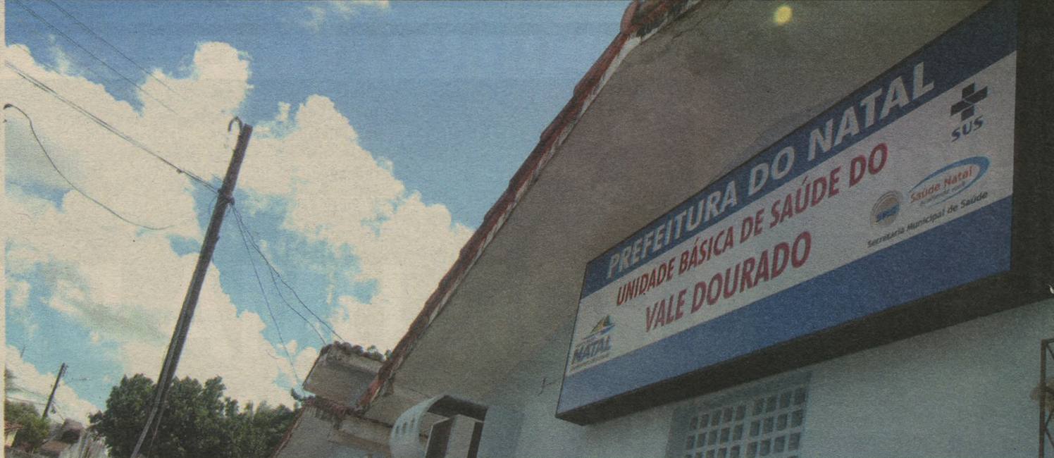
Unidade Básica de Saúde do Vale Dourado, na Zona Norte, também sofre com problemas estruturais e será beneficiado com o investimento
