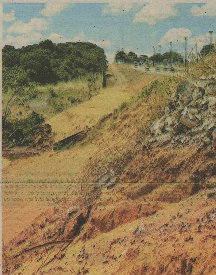
Equipe que atuava nas marginais está sendo aproveitada na duplicação
