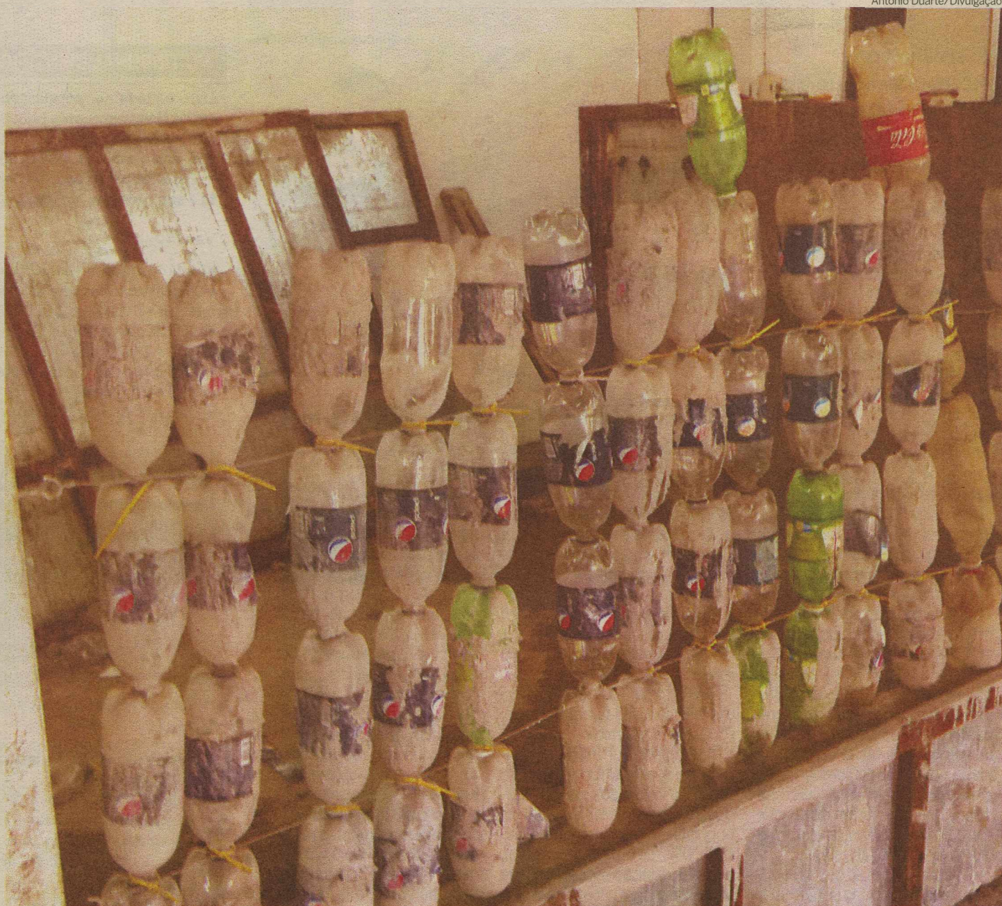
Paredes feitas com garrafas PET absorvem menos calor e requerem menos material de construção, diminuindo a utilização de areia e cimento
