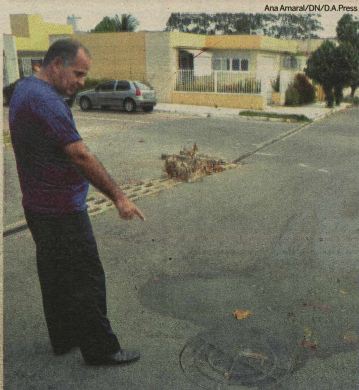
Aribeiro Araújo, do conselho comunitário, mostra vazamento em via do bairro
