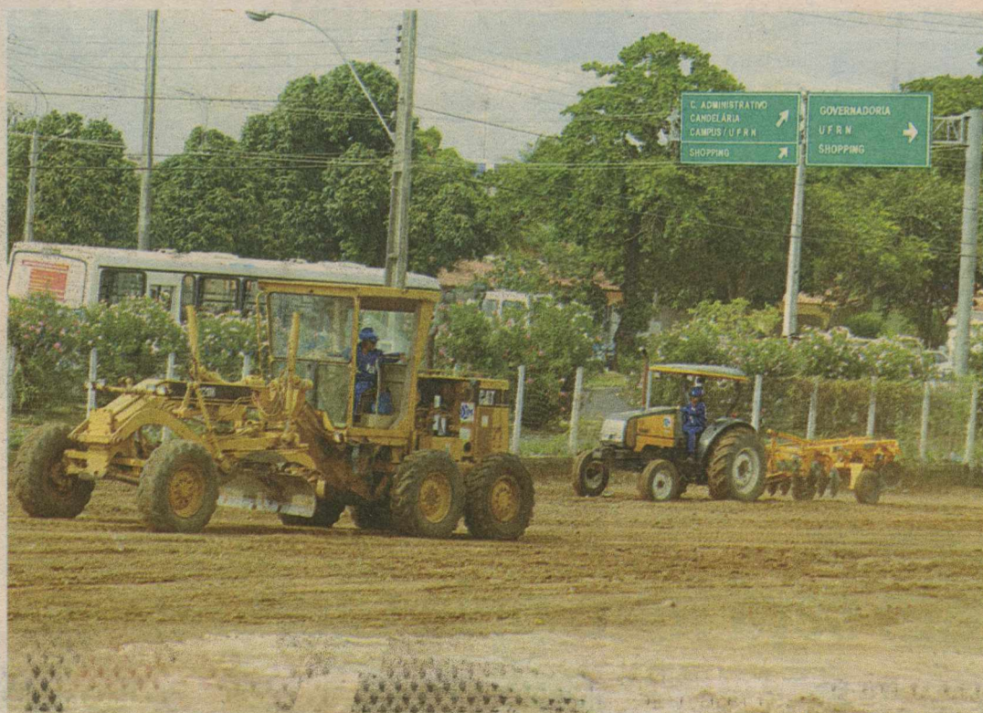
Obras de demolição do pórtico do Centro Administrativo serão vistoriadas hoje pelo Tribunal de Contas do Estado
