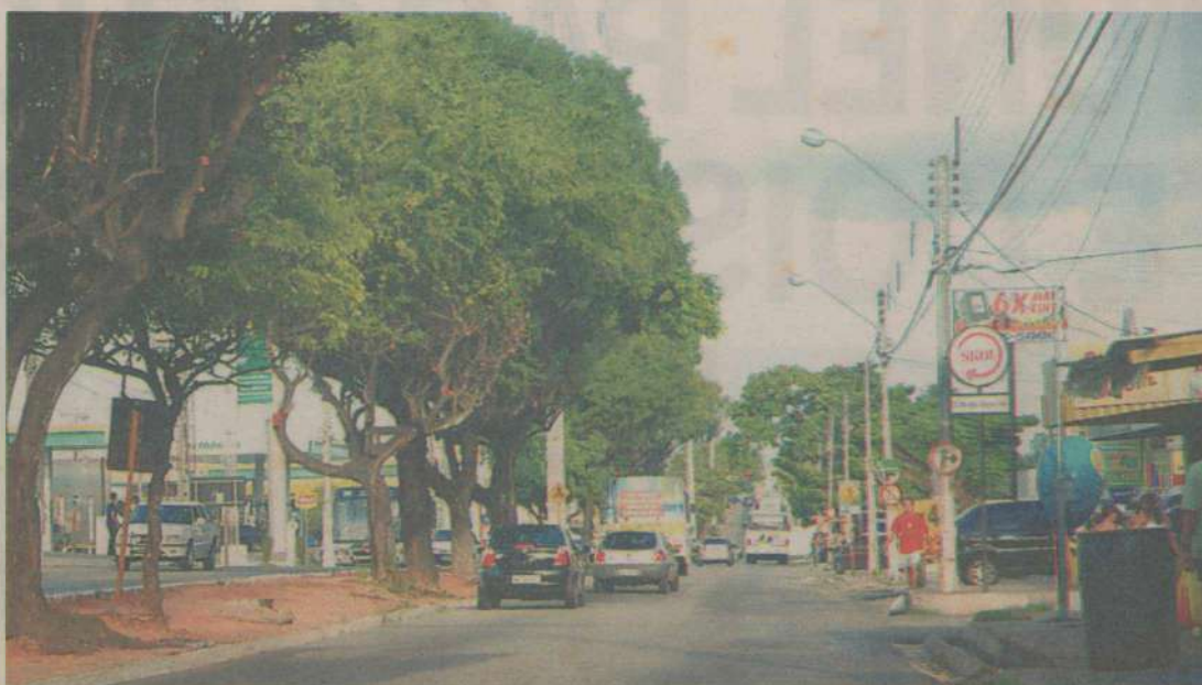
Avenida Capitão-Mor Gouveia será alargada, terá ciclovia, e viaduto será construído próximo ao Km 6
