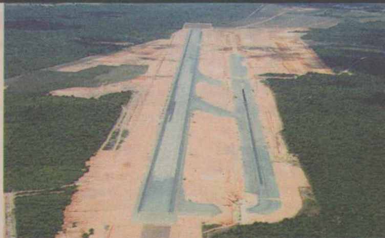
Previsão é de que obra, iniciada em 1997, esteja pronta em 2013
