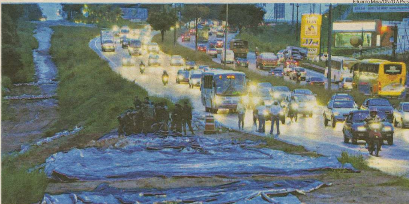
Soldados colocaram, na tarde de ontem, lonas e sacos de areia entre o canteiro da rodovia e as margens do rio Pitimbu para tentar evitar possível deslizamento
