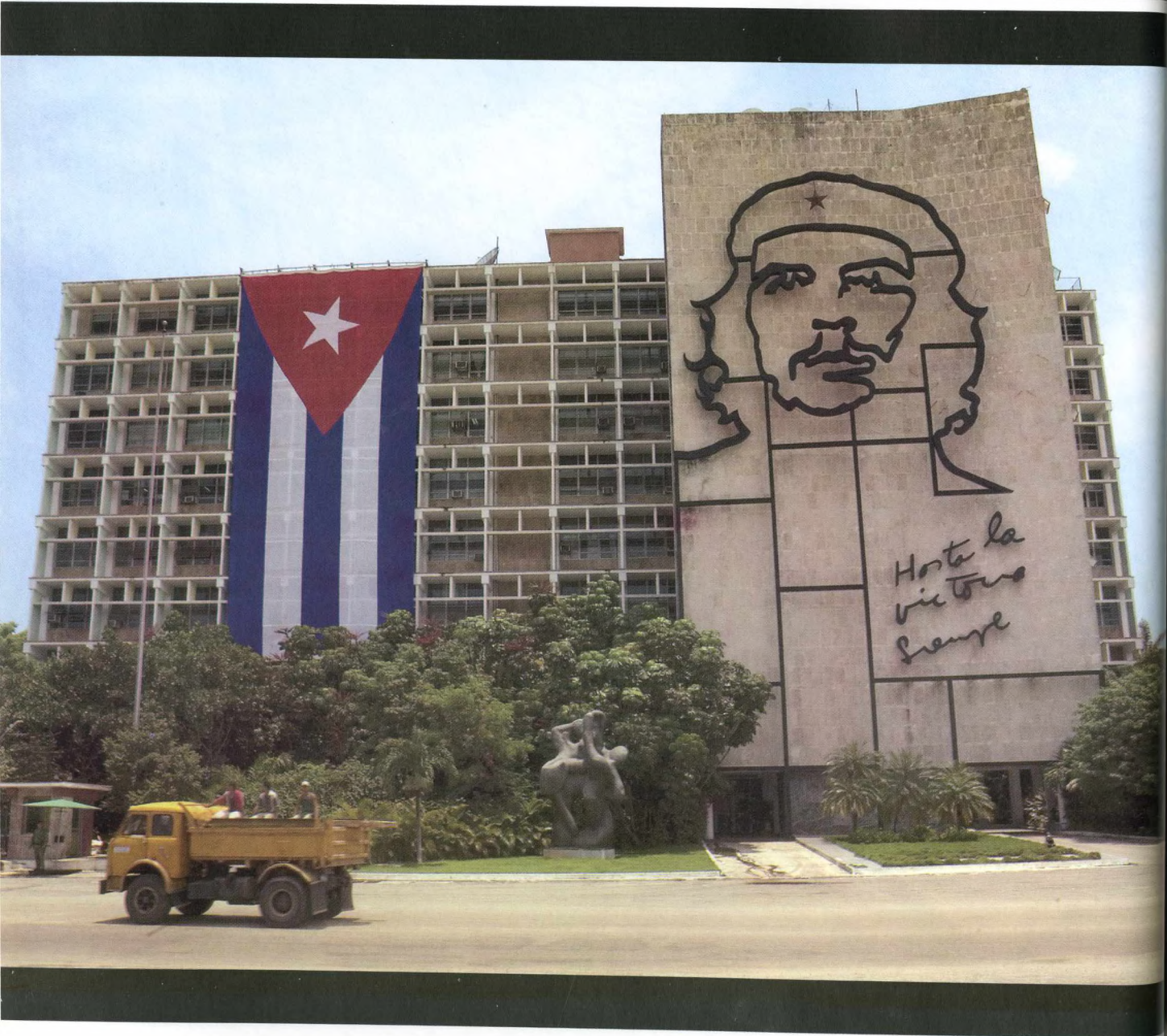
Prédio Público do centro de Havana
