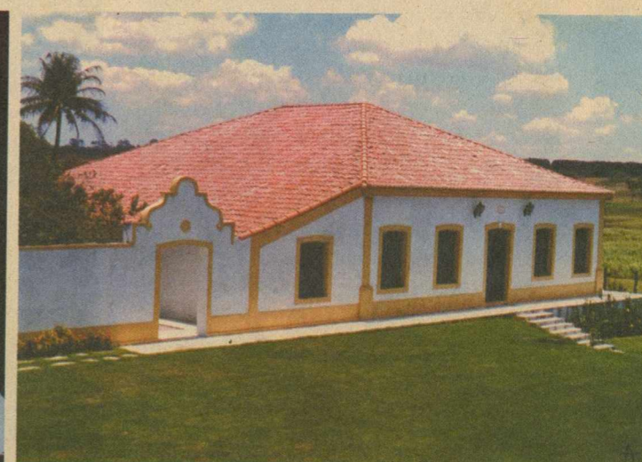
Casarão no estilo colonial, marca da região
