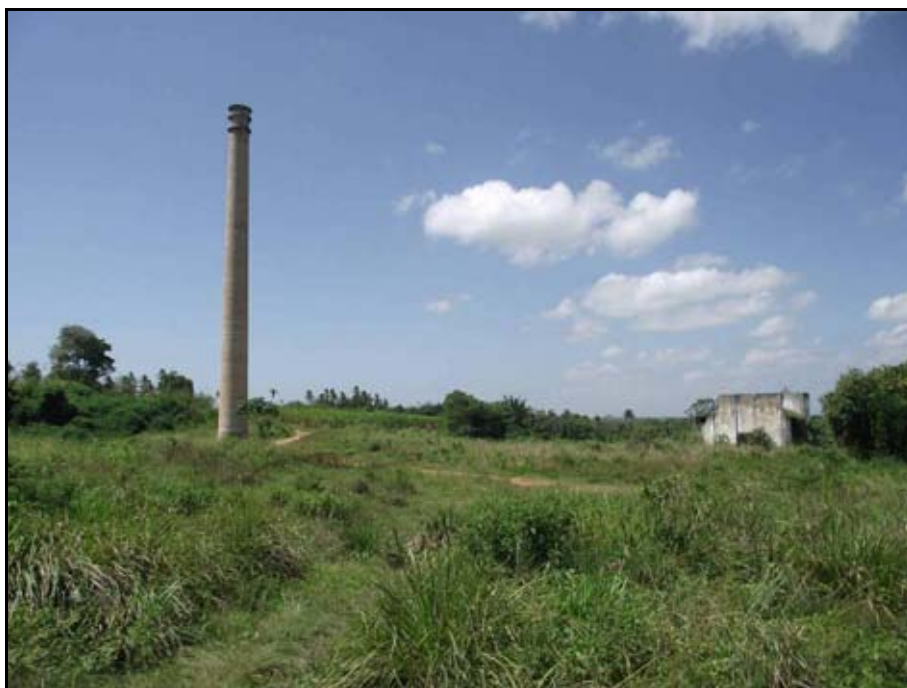
Figura 39: Ruínas da usina Santa Tereza.
