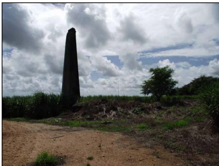
Figura 14: Ruínas do engenho União.
