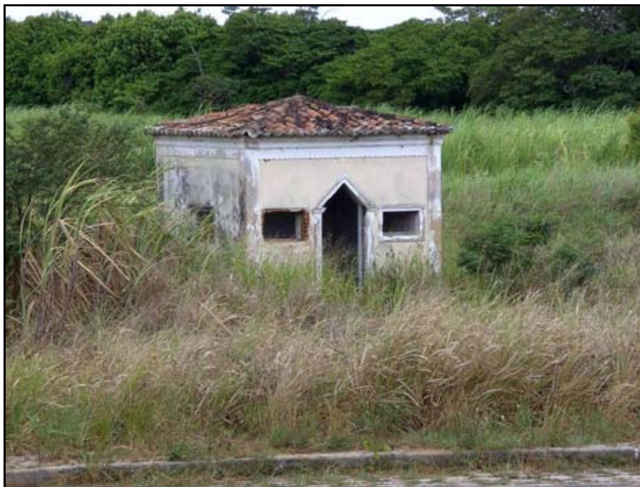
Figura 09: Casa de Banho do engenho Guaporé.
