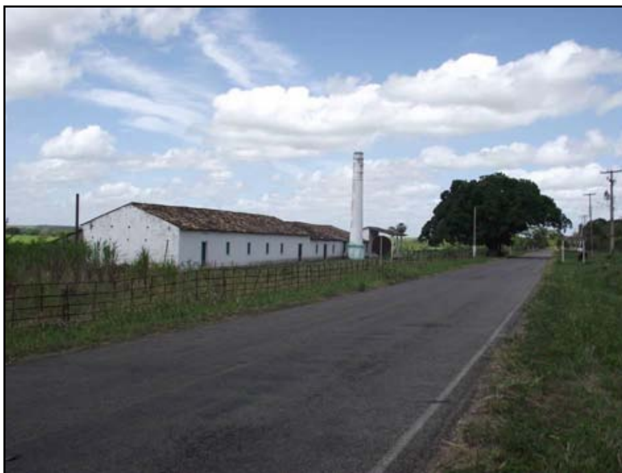
Figura 24: Engenho do engenho Verde Nasce com cerca inglesa.
