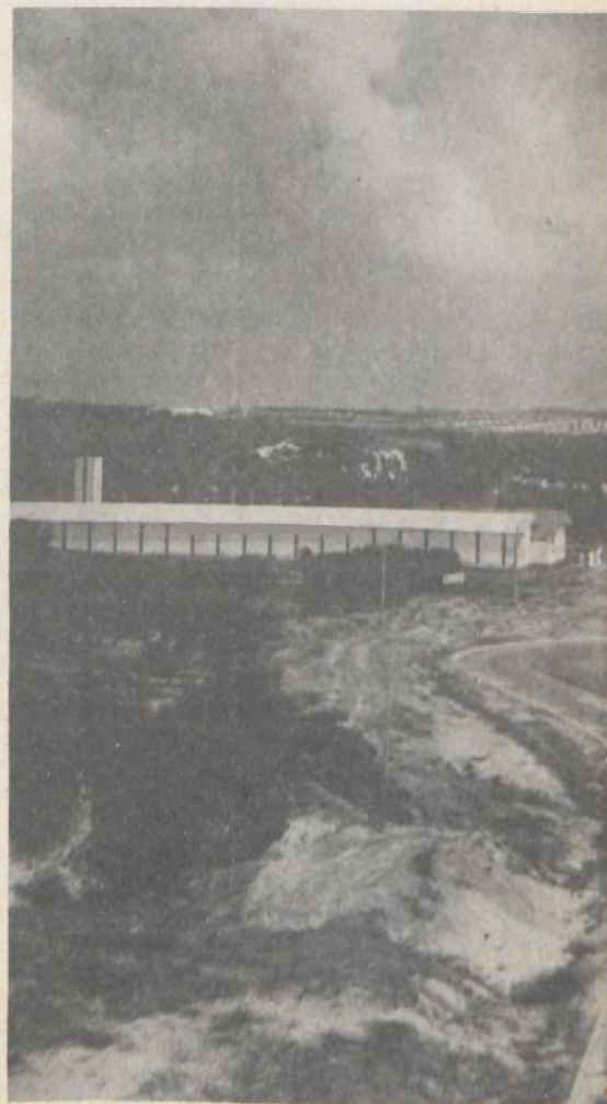
O DER constrói e conserva a malha rodoviária
