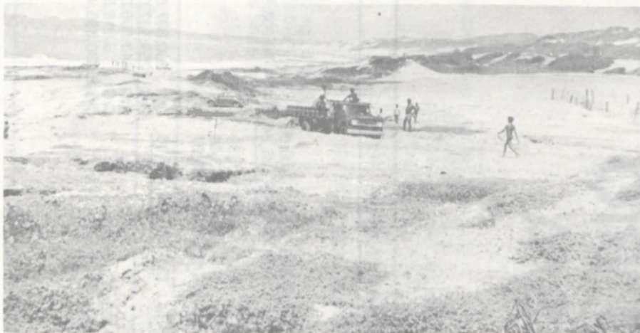
A intenção do projeto, segundo os técnicos, é preservar as dunas, pois elas estão sendo afetadas atualmente.
