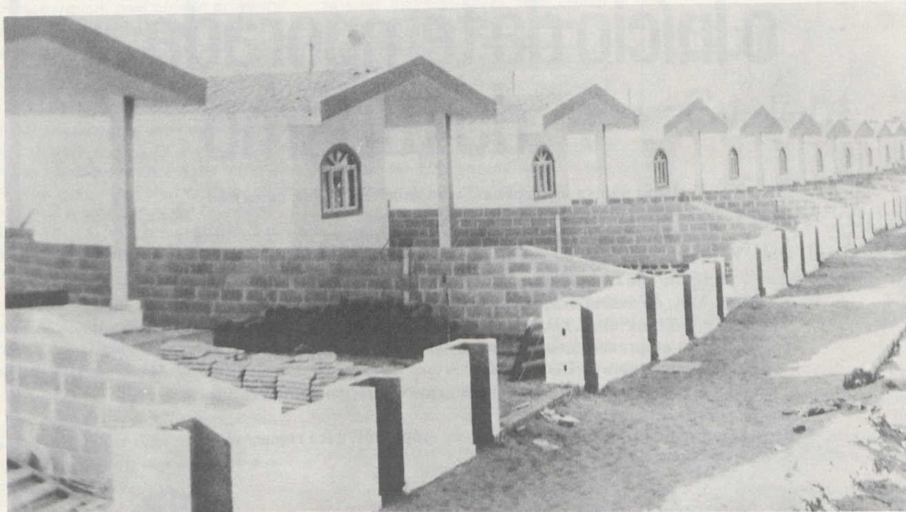
Ponta Negra é considerado o conjunto modelo construído pelo INOCOOP
