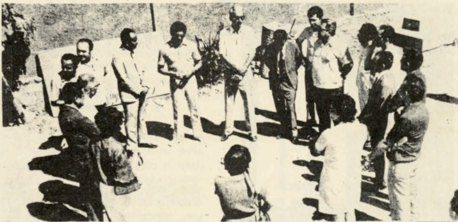
Centro de Formação Profissional de Mossoró: visita inicial, no local de sua construção.
