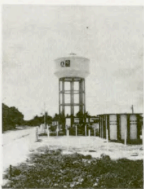
Reservatório da Cidade de Parnamirim.
