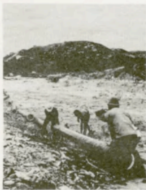
Construção da adutora de Currais Novos - 22 Km
