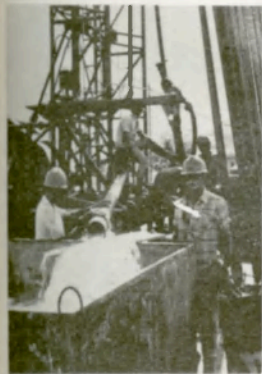
Furação de cinco poços profundos em Mossoró.
