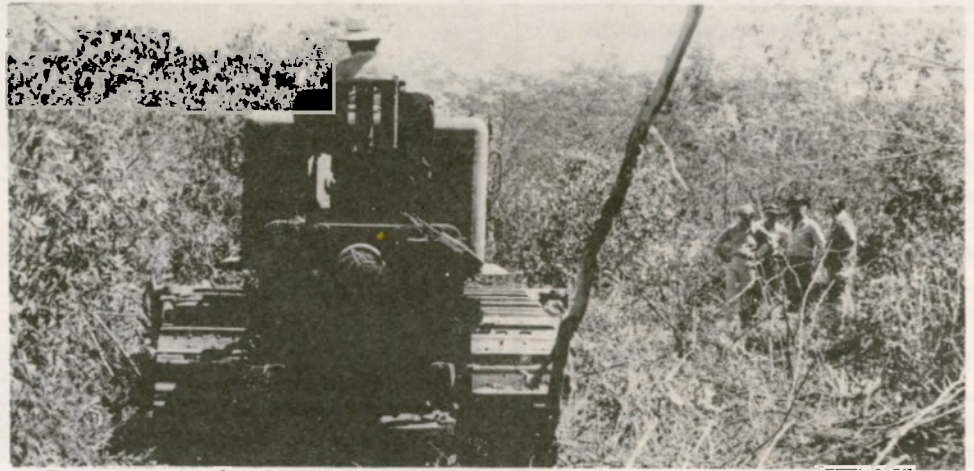
Tratores equipados com pesadas correntes fazem o trabalho de desmatamento da extensa área, em tempo recorde.
