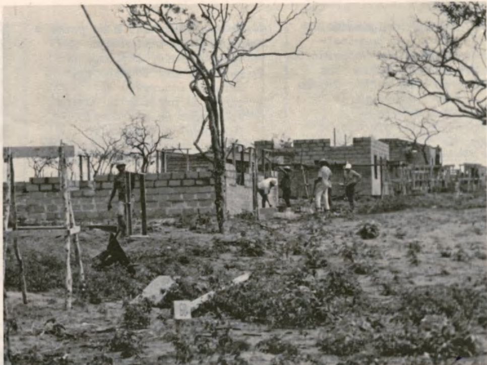
Nas Vilas Rurais, estão sendo construídas 3 casas por dia. Em maio, 320 casas estarão prontas para receber famílias de colonos.
