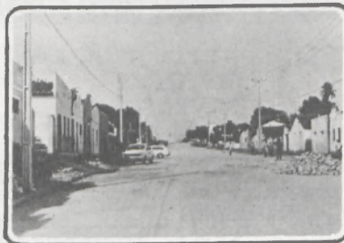
3) Pavimentação da Rua Coronel Estevam. Extensão: 1.500m. Custo: Cr$ 1.700.000,00. Construtora: CICOL. Ligará o bairro do Alecrim à Cidade da Esperança, oferecendo uma nova opção de acesso a este bairro, com 2 pistas de rolamento.
