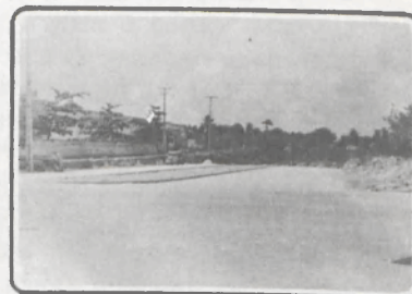
5) Pavimentação da Av. Prudente de Moraes. Extensão: 4.500m. 60.000m 2 de calçamento até o Castelão, dando uma nova opção de acesso ao Estádio. Concorrência realizada, em fase de julgamento.
