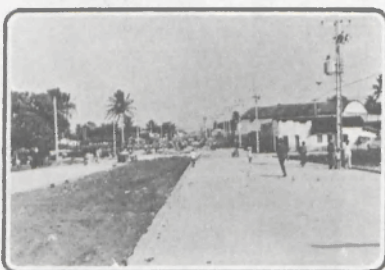
1) Pavimentação da Rua Bernardo Vieira (Av. Leste/Oeste). Extensão 4.500m. 75.700m 2 de calçamento. Custo: Cr$ 3.650.000,00. Construtora: CIMOB, com 2 pistas de rolamento. Esta Avenida/passará pelo Morro Branco, Lagoa Seca, Dix-Sept Rosado, Alecrim e Quintas. Mudará o tráfego nos sentidos entrada/saída da cidade e possibilitará a determinação da mão-única para a Rua Mário Negócio.
