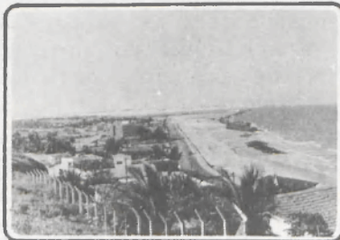
4) Pavimentação e urbanização das praias. Construção de canteiros, mirantes, estacionamentos e fixação das dunas. Extensão: 4.500m. 70.000m 2 de asfalto e 20.000m 2 de paralelepípedos. Custo: Cr$ 7.000.000,00. Construtora: CICOL.
