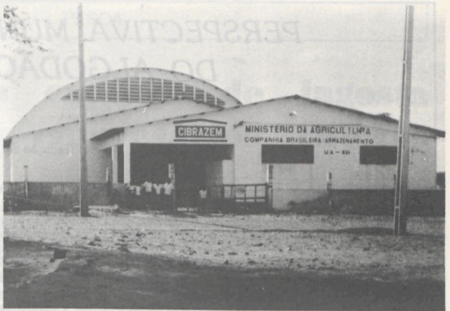
Armazém do tipo convencional, construído pela CIBRAZEM.
