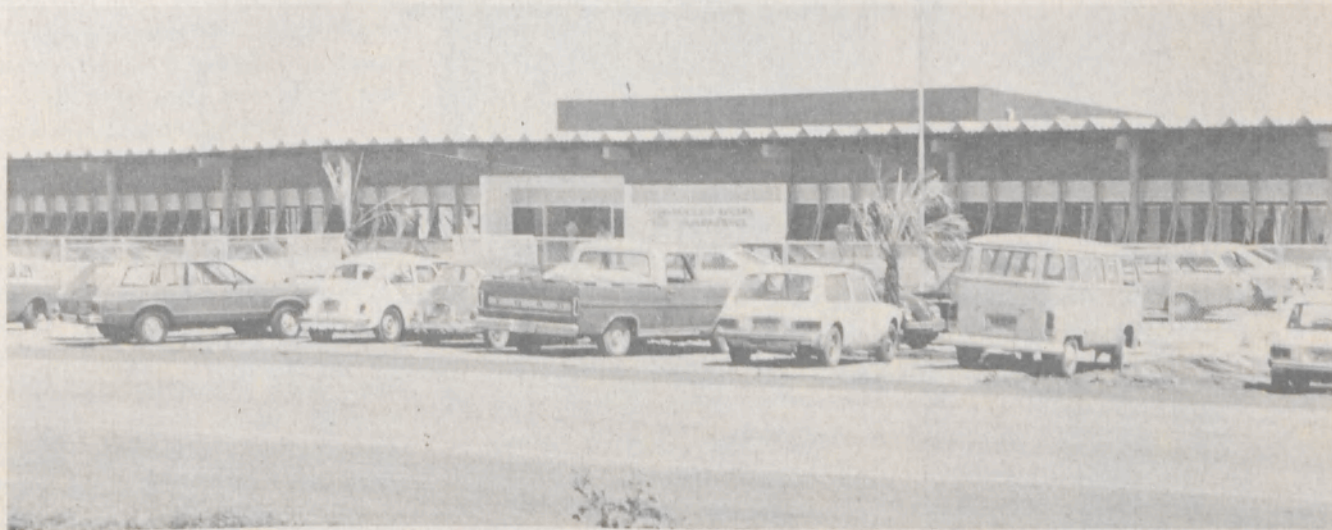
Com a inauguração do Núcleo Social, as instalações da Guararapes em Mossoró passam a ocupar uma área de 12.200 m 2 , oferecendo 838 empregos.
