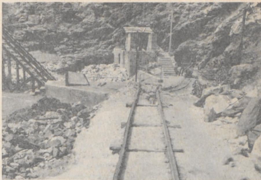
Uma denúncia: "Os produtores de scheelita do RN estão subsidiando as indústrias de manufaturados de tungstênio do Sul".
