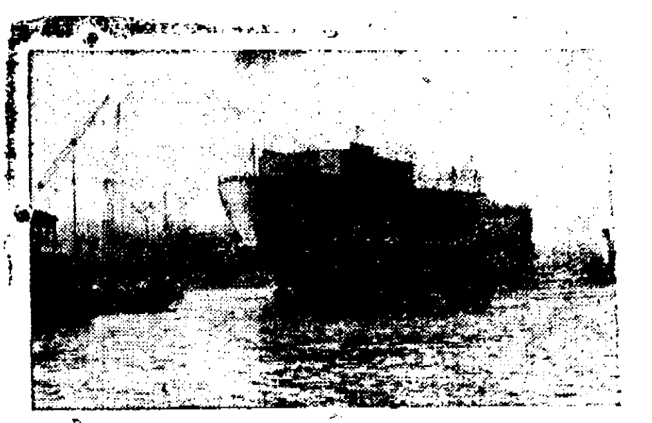
A primeira metade do navio tanque de 23.000 toneladas, "Rondezoll", construído para a firma de Oslo, de Oslo e Vebstad, foi lançado ao mar no estaleiro Sunderland de John Crow and Sons. Foi construído em duas metades por que não há carreira suficiente grande para conter o navio inteiro. A foto mostra uma metade do tanque depois de ter sido lançada ao mar em Sunderland. — BRITISH NEWS
