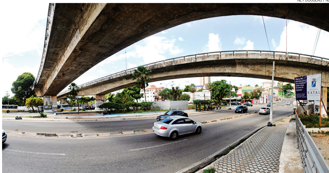
▶ Avenidas Deodoro e Rio Branco, no trecho abaixo do Viaduto do Baldo: laudo pode evitar interrupção do trânsito
