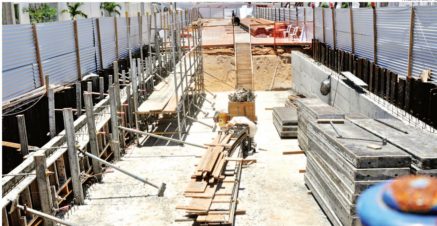
► Entre as obras executadas pela Prefeitura estão túneis e viadutos no entorno do estádio que, segundo especialista, inviabilizam a mobilidade de pedestres
