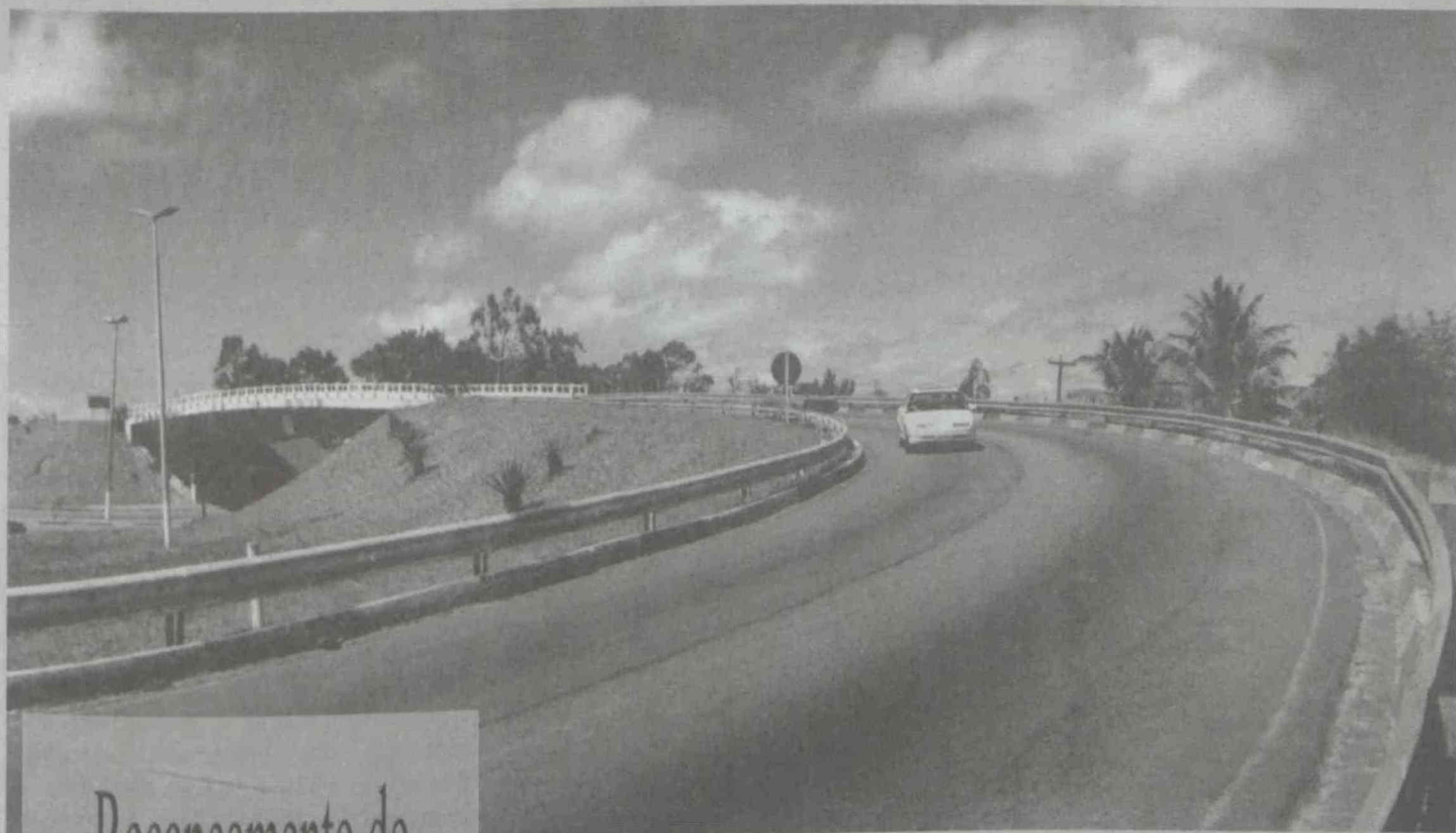
ACESSO AO VIADUTO DE PONTA NEGRA
