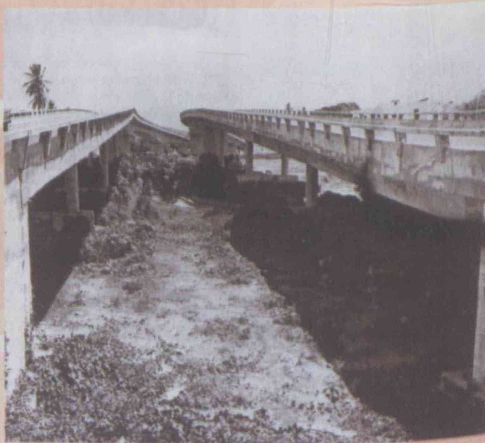
OS VIADUTOS DO BALDO
