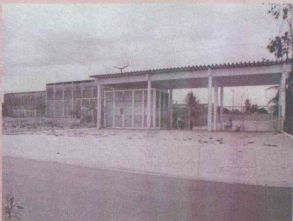
UMA DAS CONSTRUÇÕES DA ALGIMAR NA ESTRADA DA REDINHA (NATAL-RN)
