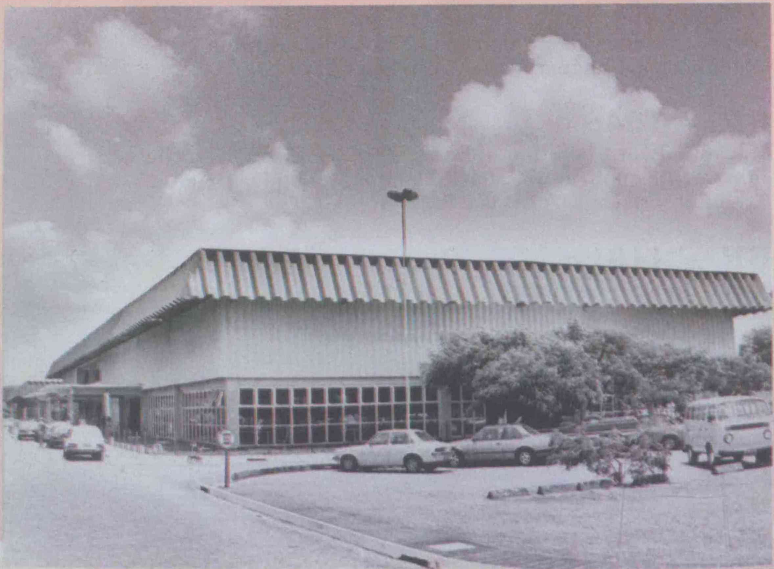
TERMINAL RODOVIÁRIO DE NATAL - NA CIDADE DA ESPERANÇA
