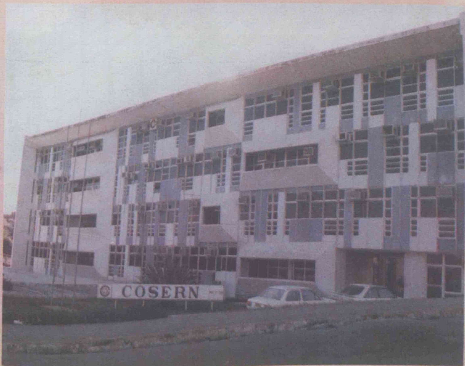
EDIFÍCIO SEDE DA COSERN - NO BALDO (NATAL-RN)
