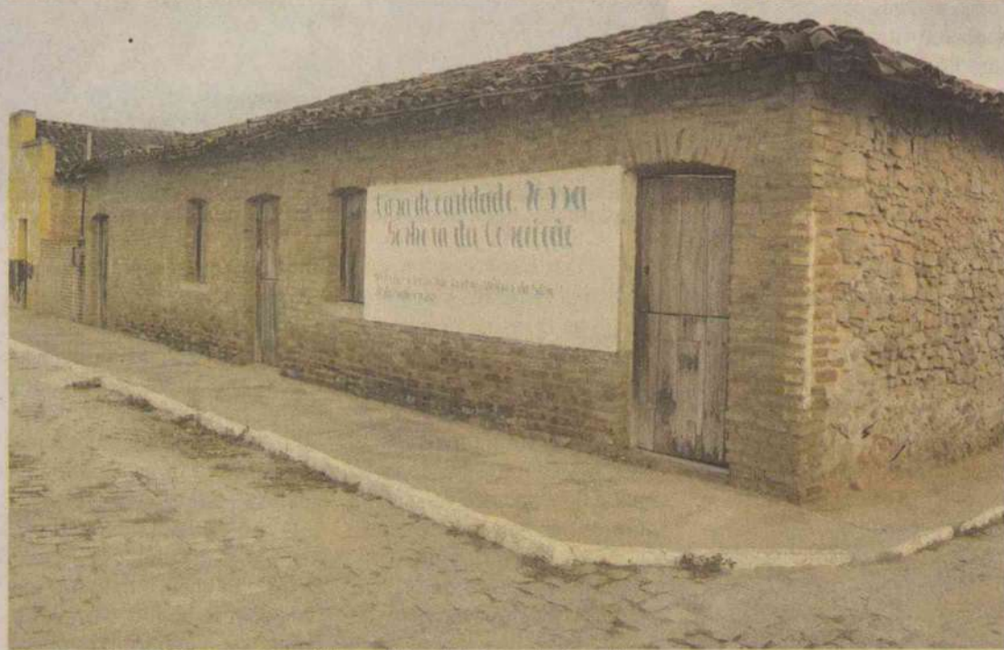
Estrutura é de 1854 e uma das últimas feita de taipa entrelaçada por couro cru de boi
