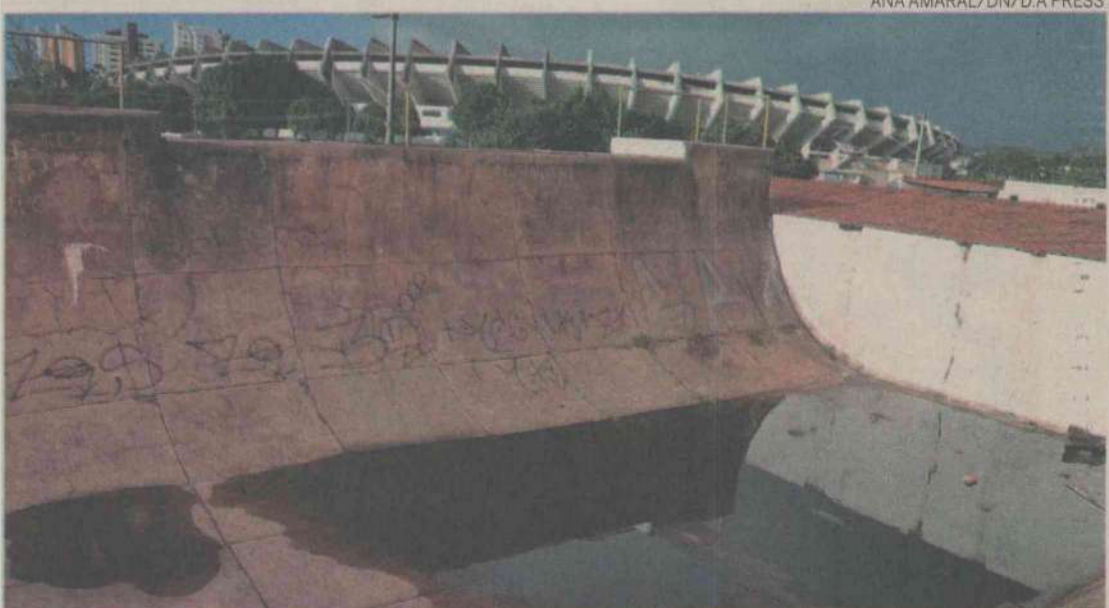
Com rachaduras e esburacada, única pista da cidade está impraticável há anos
